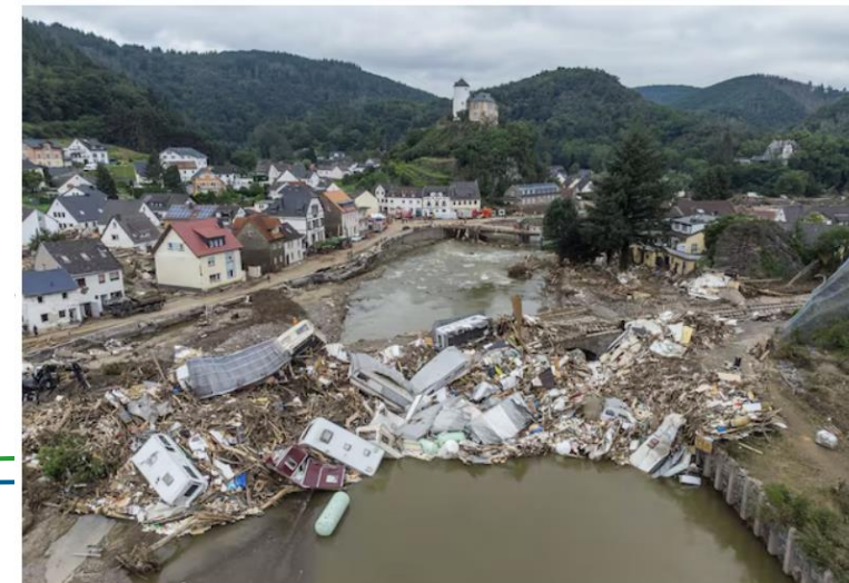
Wohnwagen, Gastanks, Bäume und Schrott türmen sich an einer Brücke über der Ahr.
