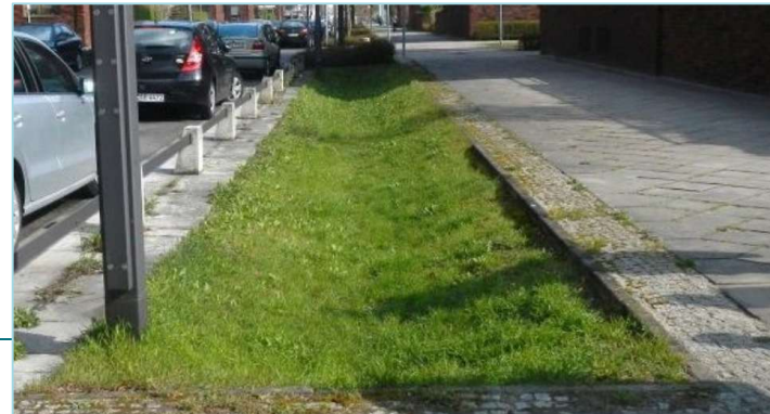
Aufbau Versickerungsmulde (DWA A-138-1)
