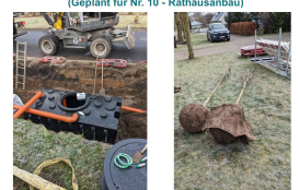
Beispiel: Einbau von Baum-Rigolen am Fritz-Mackensen-Weg (Foto: Uni Rostock)
