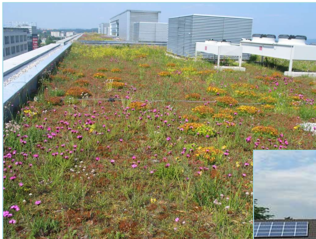
Extensive Dachbegrünung (gruenwert.at)
