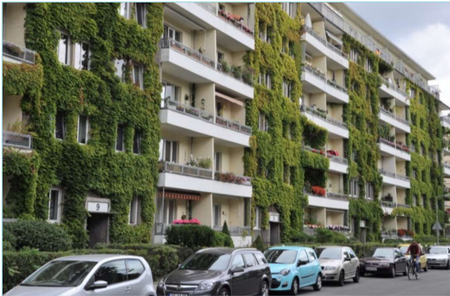
Erdgebundene Fassadenbegrünung (kuras)
