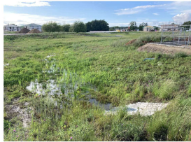
Gewässer- und multifunktionale Flächenanwendung von Grünflächen als Regenwasserbewirtschaftungsflächen in Kiefernweg zum Regenwasserrückhalt (Foto: Volter)
