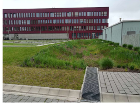
a) Mulde für Regenwasserrückhaltung und Versickerung (Foto: Schröder)
